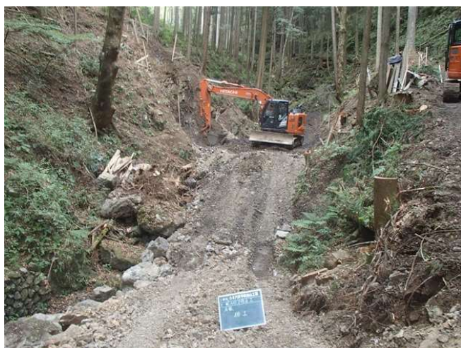
施工中 (谷止工)
