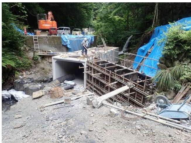
施工中（ボックスカルバート）
