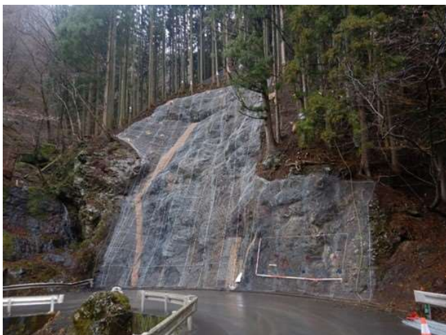
施工中(簡易法枠工)
