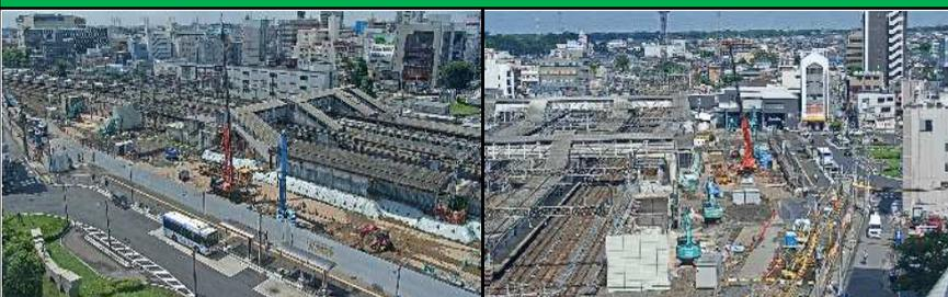
① 旧東口駅舎やその他建物・鉄道設備等の解体が完了し、伊勢崎線仮上りホーム・南北連絡通路の杭工事を実施しています。また、伊勢崎線仮上り線の敷設に向けて、盤下げ工・路盤工も順次進めております。
