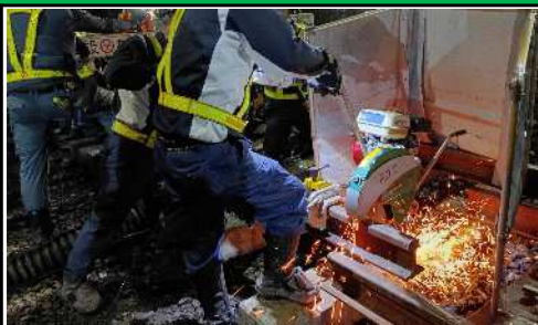
レール切断作業
