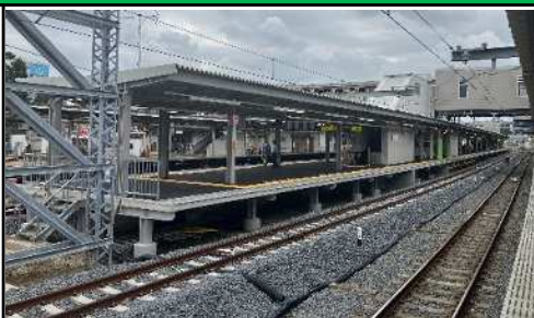
仮下りホーム 全景
