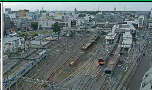
伊勢崎線仮下り線切替え後
