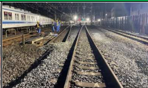
線路切替え後
