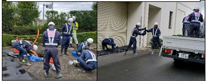
排水ポンプ・土嚢の設置(建設協)
