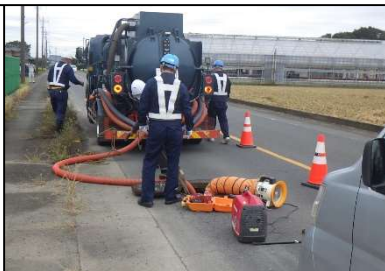
吸引車による汚水の移送(管路協)
