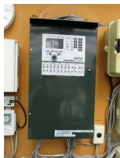
統合環境制御装置
