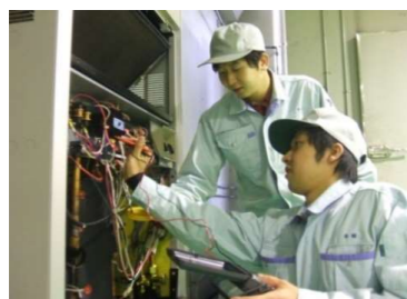
(業務用エアコン点検の実習)
