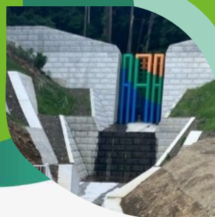
砂防関係施設整備
