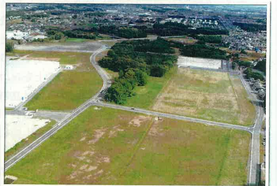
▲農大跡地西上空から東側を望む。農大跡地周辺における産業支援施設の整備は、今後、急速に進むであろう「超スマート社会(Society5.0)」に対応し、DX(デジタルトランスフォーメーション)を力強く進めるための最重要課題として推進しなければならないと考えています。
