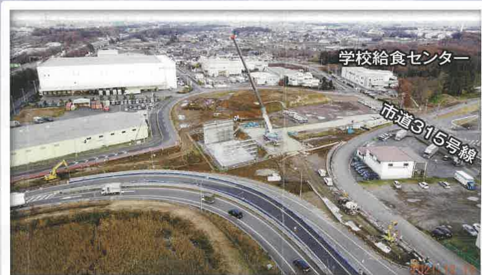
▲写真撮影：NEXCO東日本 所沢管理事務所 / 令和3年12月10日現在
