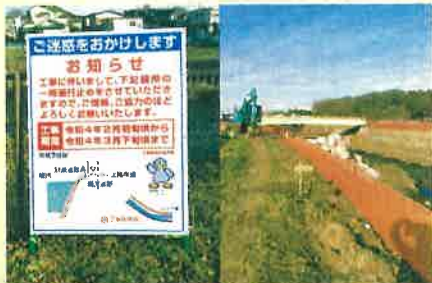
1級河川「鴨川」改修工事のを順次進めております。現在は、土手の護岸工事が進められています。(県事業)
