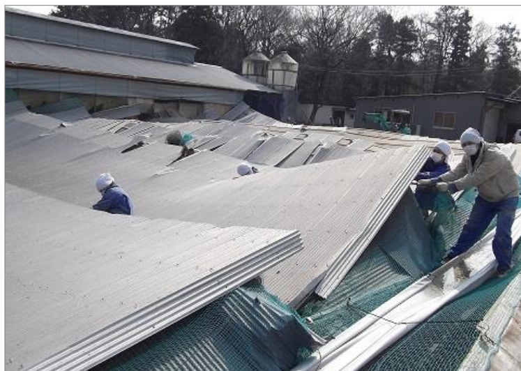
写真 3 倒壊した鶏舎の屋根（解体工事中）
