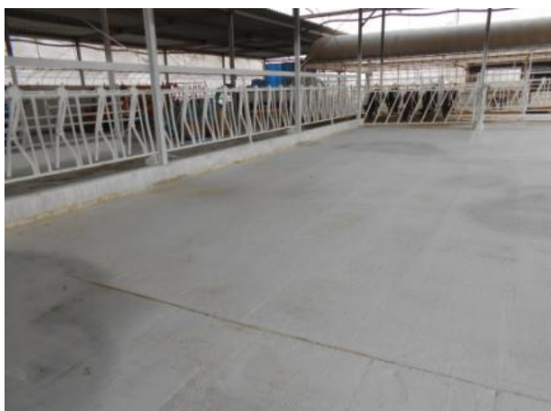
図6 石灰乳を塗布した牛舎
