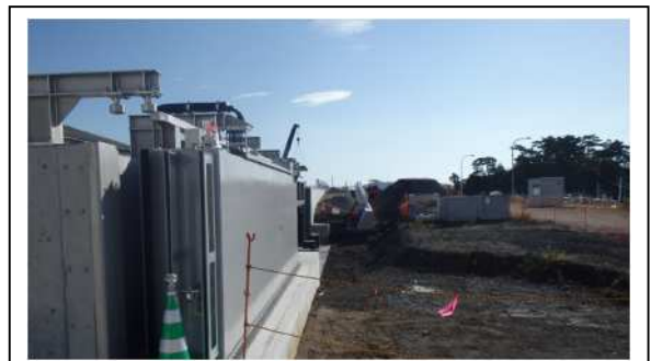
塩釜 陸閘 防潮堤 工事中
