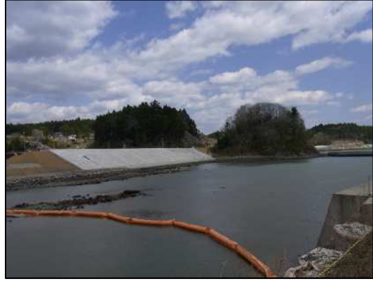
【伊里前漁港伊里前地区の防潮堤】
