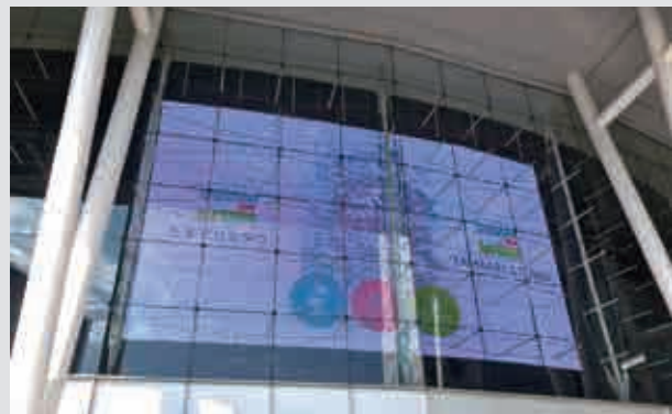
▲建物正面に設置された大型LEDビジョン
