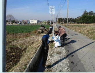
水路の泥上げ
