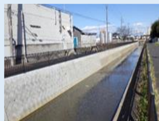
整備工事が完了した「会の川」
