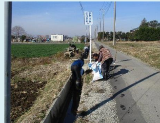
水路の泥上げ
