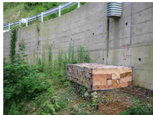
軽量であるため河岸擁壁の基礎地盤に負担をかけない。
