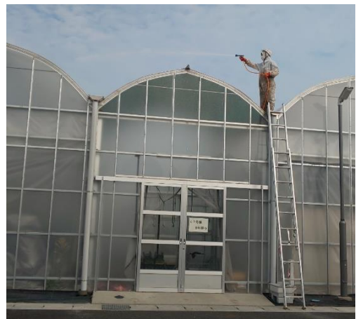
図6 高軒高ハウス屋根への散布
