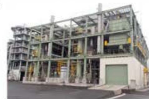
固形燃料化施設
