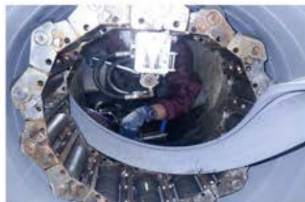
管渠の補修工事
