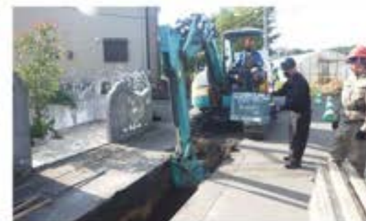
汚水の管渠工事
