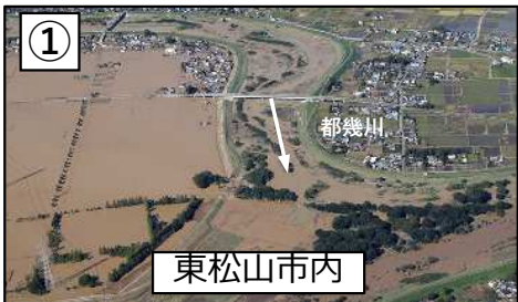
令和元年 東日本台風
