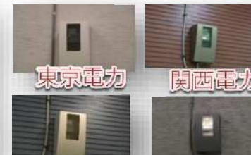
スマートメーター
