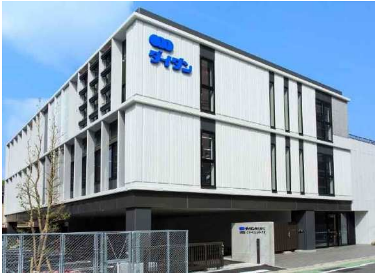
2016年竣工 九州支社 ZEB Ready
