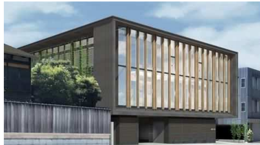
2022年竣工 北陸支店 ZEB Ready
