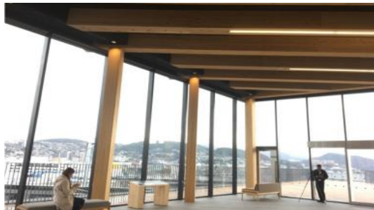
長崎県庁舎(竣工2018年) 行政棟8階展望施設の柱梁に 純木質耐火集成材を採用 (出典:長崎県 HP)
