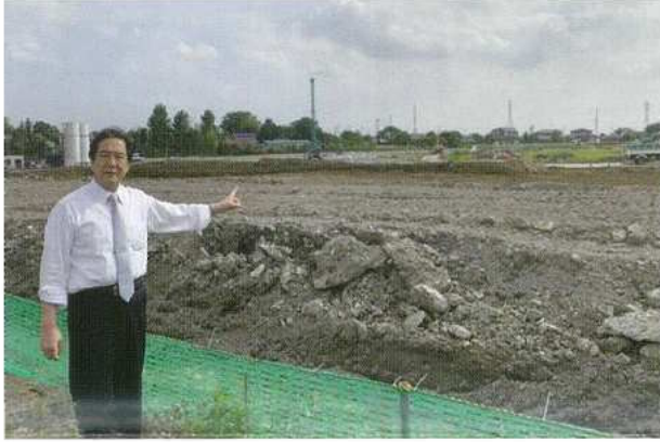
宮代町和戸北部(横町)の工業団地造成工事現場
