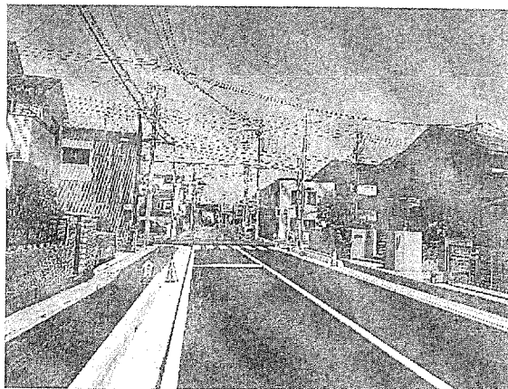
交差点に交わる拡幅整備した市道(久喜市施工)
