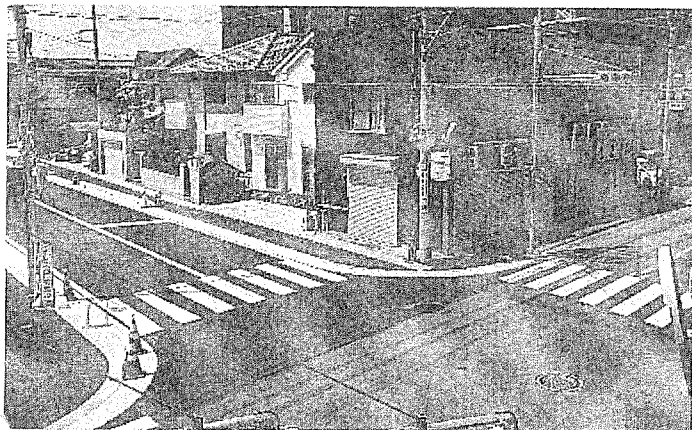
交差点を整備して信号機を設置した後
