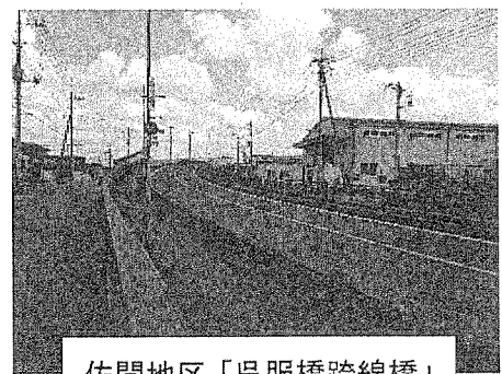
佐間地区「呉服橋跨線橋」
