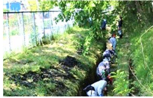
地域住民による水路の泥上げ活動
