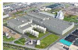
高度浄水処理施設(整備中)
