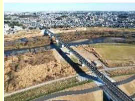
長大橋の建設
