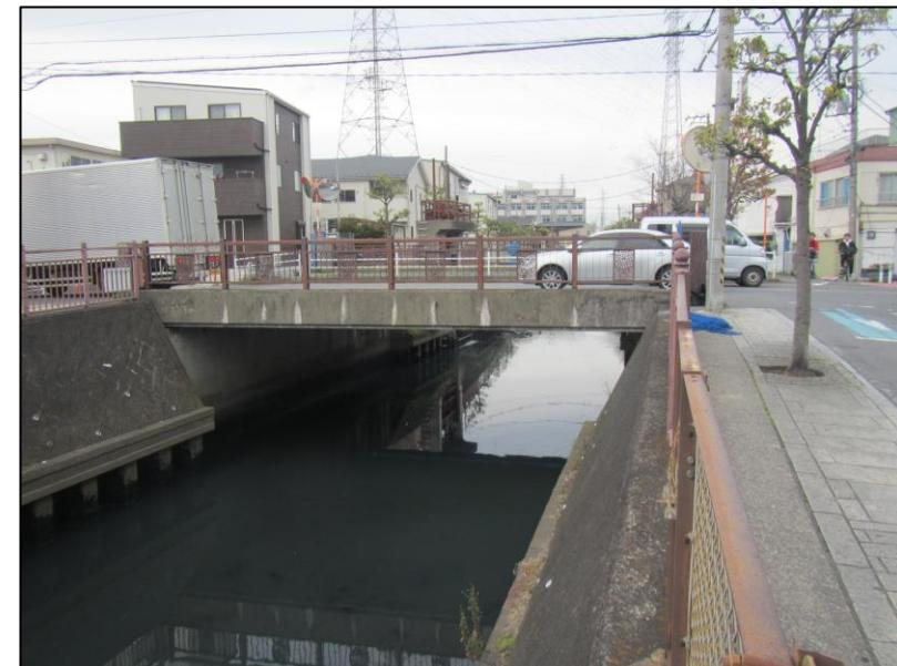
埋設物や電線・電柱の移設完了後、辰井橋の架け替え
