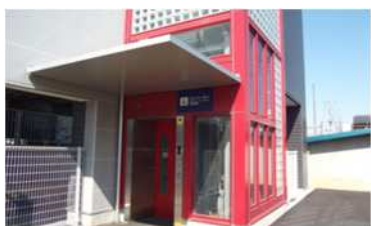
障害者対応型エレベーター
