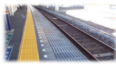
内方線付き点状ブロック
