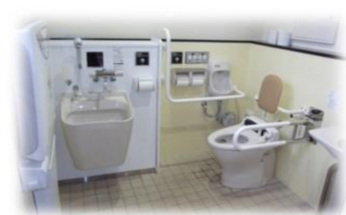
障害者対応型トイレ
