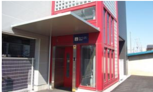
障害者対応型エレベーター
