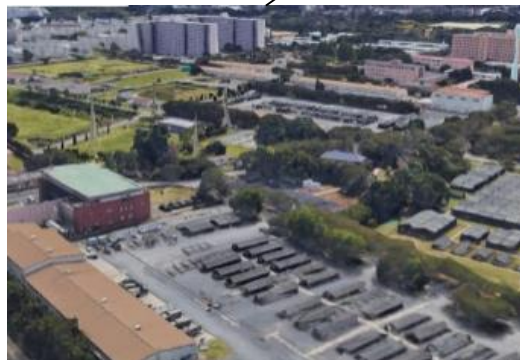
埼玉県新座防災基地 陸上自衛隊朝霞駐屯地
