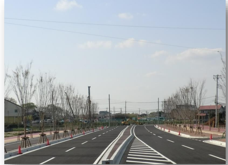
モデル工事区間（志木市）
