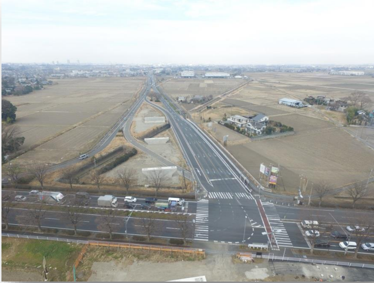
国道463号陸橋工事（富士見市）
