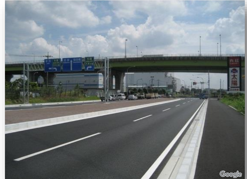
外環道付近完成区間（和光市）
