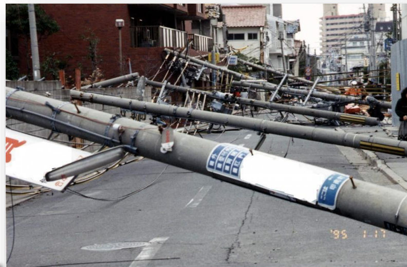
地震時の電柱倒壊（阪神淡路大震災）
