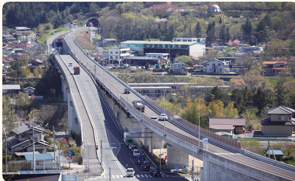
国道 140 号 皆野秩父バイパス
