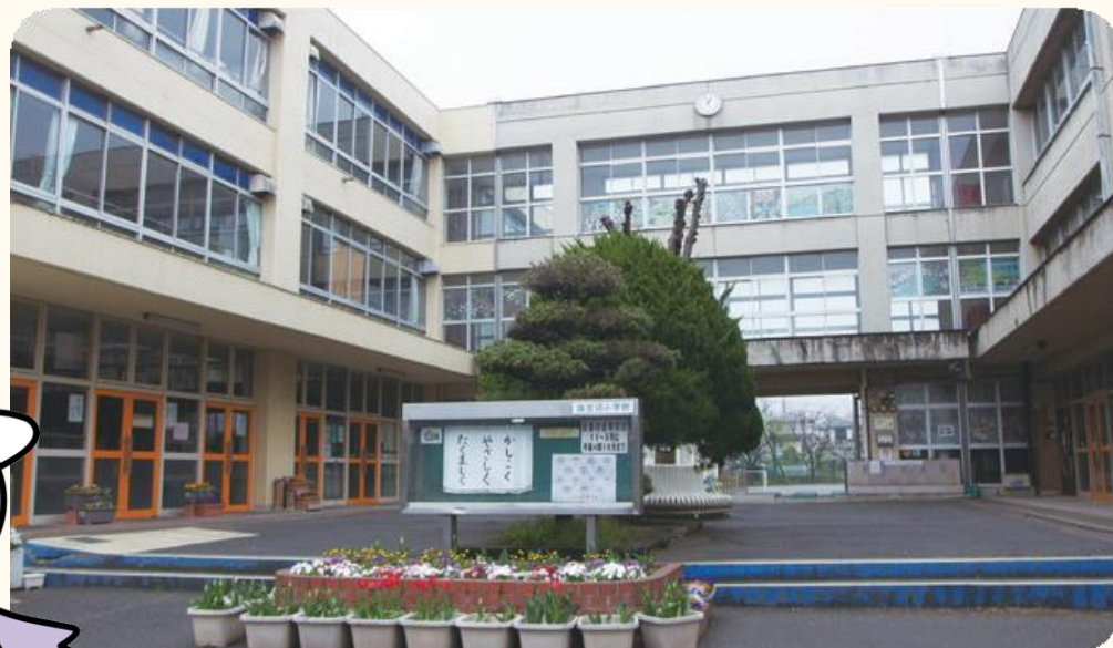
整備された校舎
