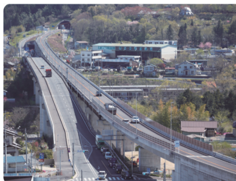
国道140号 皆野秩父バイパス
