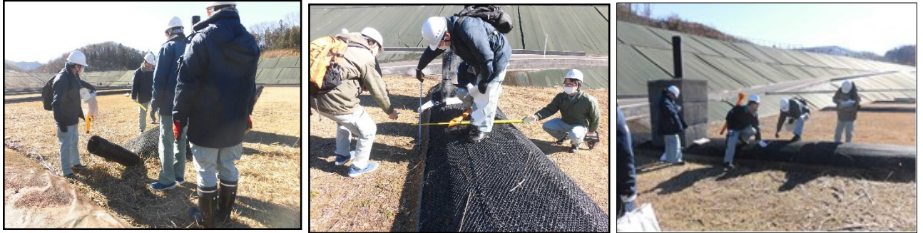
最終処分場への立入検査の様子
