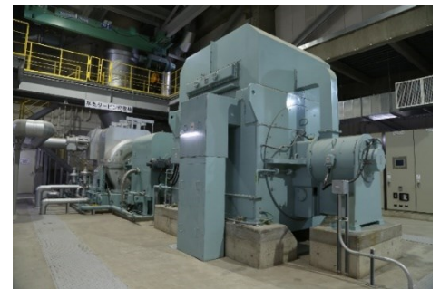
熱回収設備（蒸気タービン発電設備）
