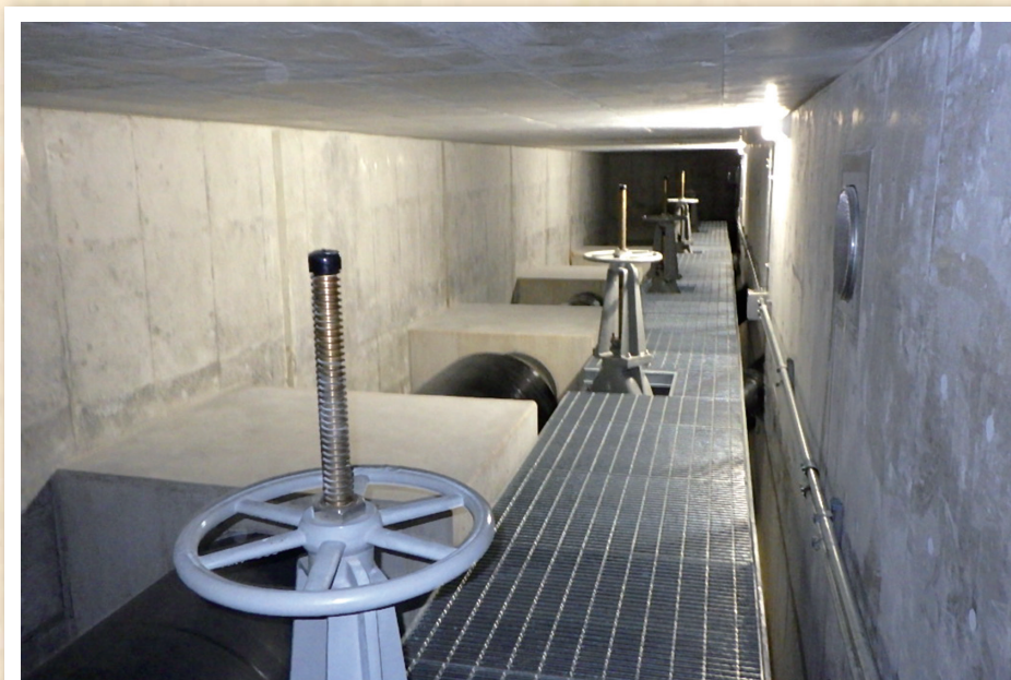
柿木浄水場場内配管整備(配水本管)
