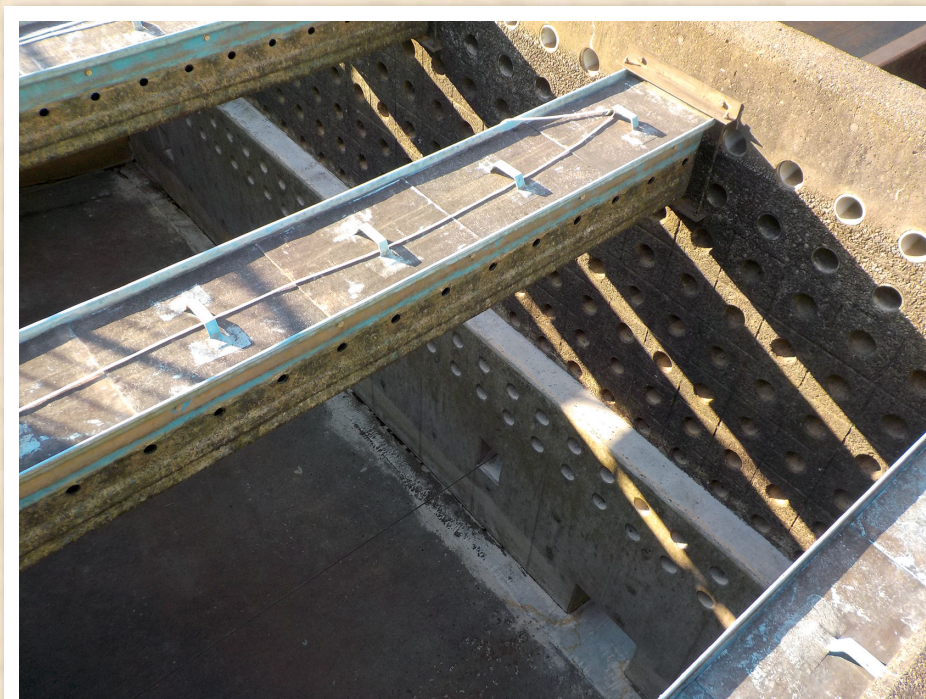
柿木浄水場1系5号沈でん池耐震補強工事
