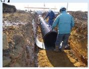
水田地帯で本格的な野菜生産が行 えるよう、排水路を深くして排水効 果を高め、地下水位を低下させる。
