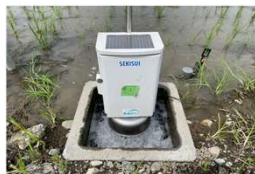
バルブの開閉作業
