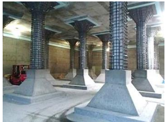
浄水池耐震補強工事事例【部材厚増】
