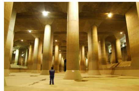
②首都圏外郭放水路（P10参照）
