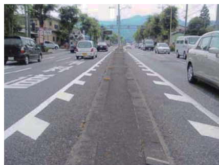
コンクリートで被覆
