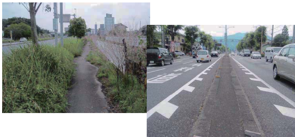
(中央分離帯における焼却灰の再生砕石敷設状況)
