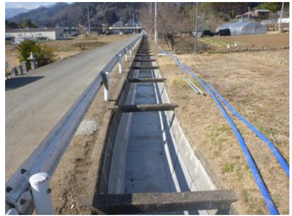
開水路補修施工状況
