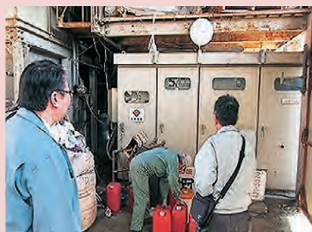
PCB廃棄物立入検査
