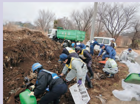
ボランティア活動による廃棄物の撤去
