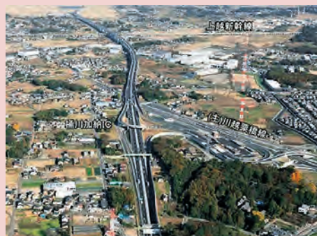
圏央道桶川加納インター付近
