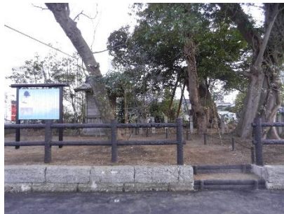
出入り口及び柵の整備
