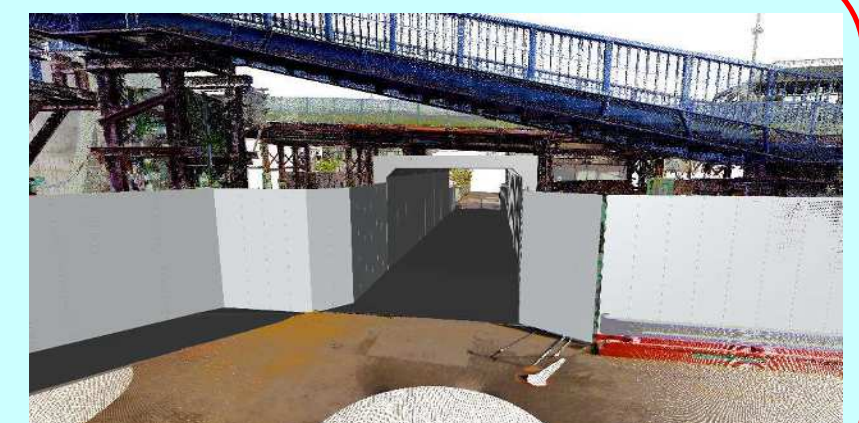
※南側歩道出入口(武蔵藤沢駅側)全景※
