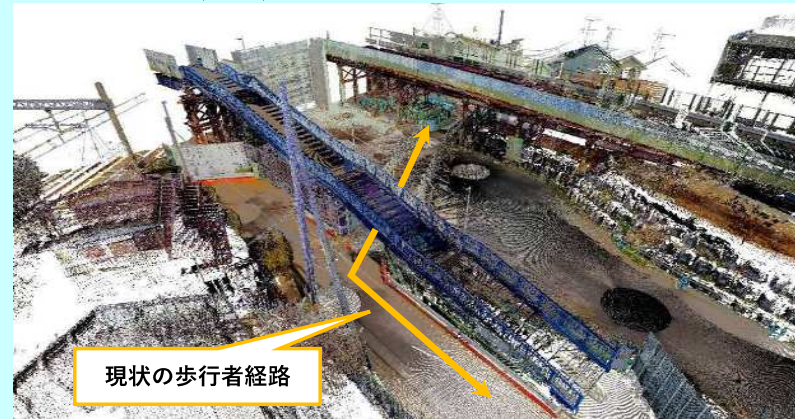
【①工事施工前(現況)】
