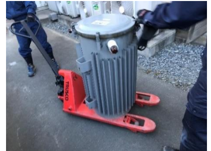
PCB廃棄物の適正処理
