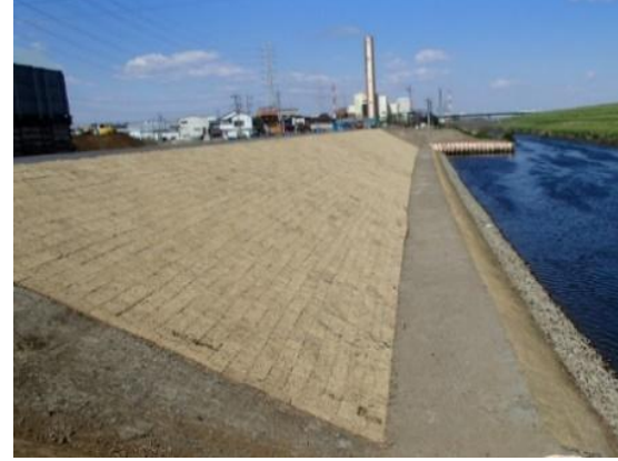
築堤・河道拡幅（整備後）
