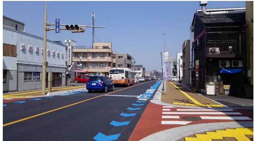
整備済みの中央通停車場線（2工区）
