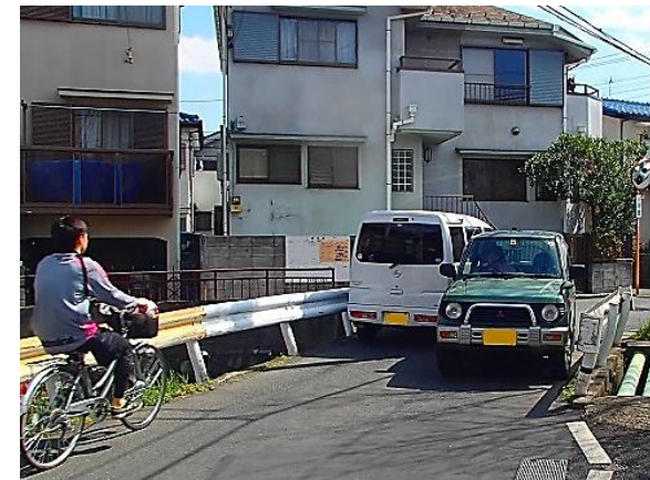
県道練馬所沢線の現状
