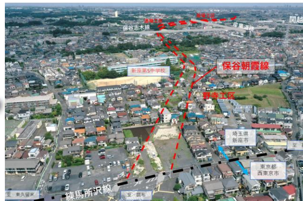
野寺工区：都県境から北側を望む
