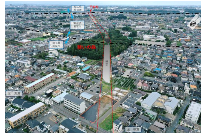
新堀工区：南側から北側を望む
