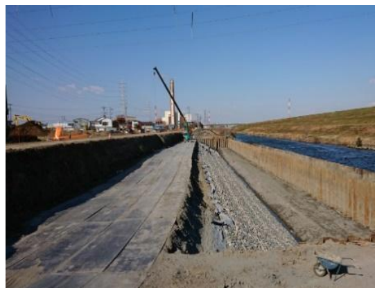
築堤・河道拡幅（整備中）
