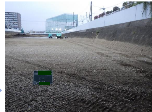
堆積土砂撤去
