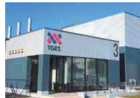
清原スマートエネルギーセンター
