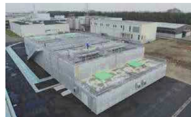
行田浄水場着水井完成の様子
