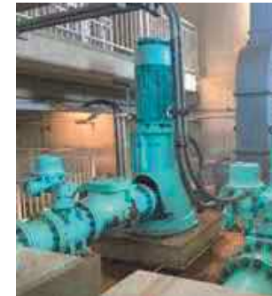
吉見浄水場2号表洗ポンプ設備更新工事
