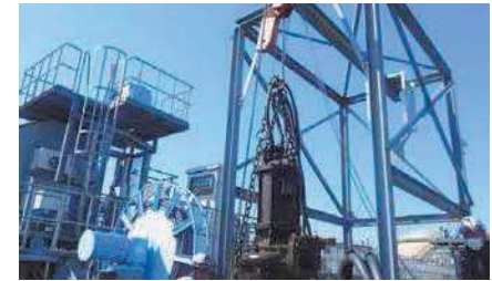
排砂ポンプ（4号）の取付の様子
