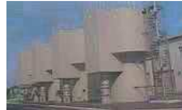
高度浄水処理施設(オゾン接触池)
