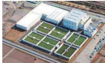
大久保浄水場排水処理施設(PFI事業)
