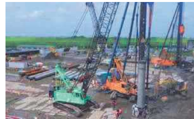
高度浄水処理施設杭設置工事の様子
