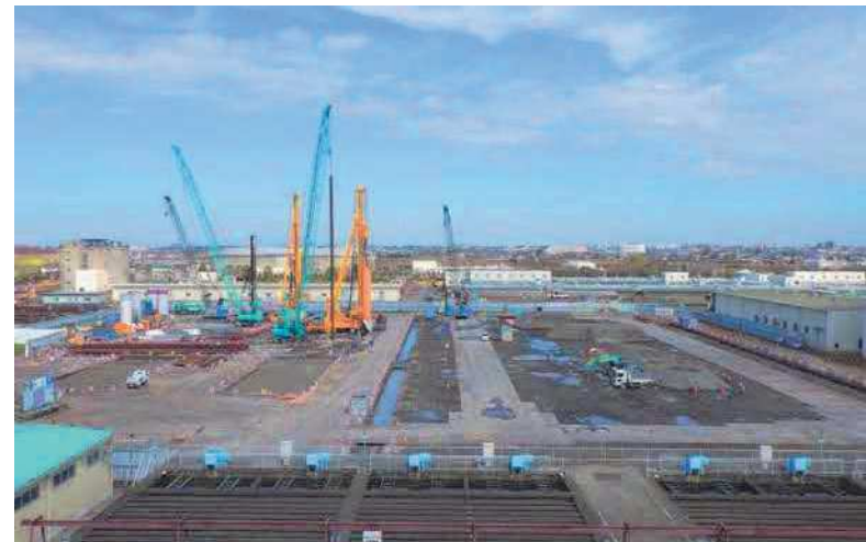
大久保浄水場高度浄水処理施設の工事状況
