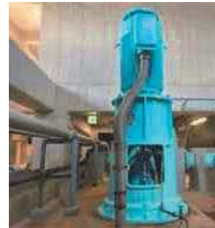
吉見浄水場2号表洗ポンプ設備更新工事
