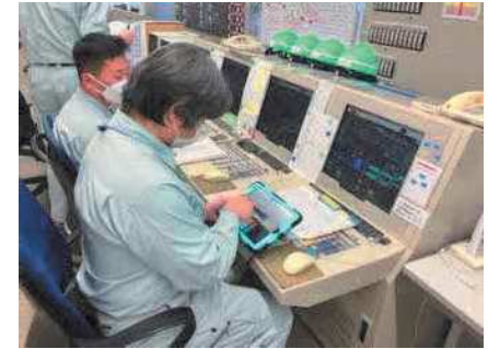
タブレット端末を使用した点検の様子
