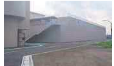
高度浄水処理施設(生物活性炭吸着池)
