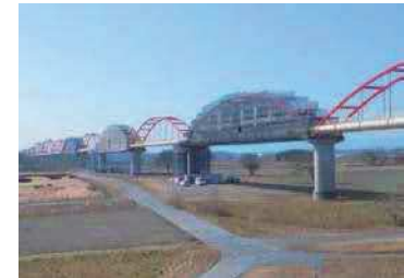
各工区仮設状況
