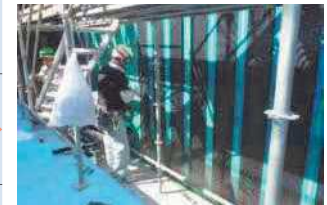
新三郷浄水場薬品沈でん池
