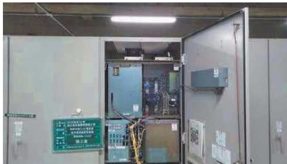
施工後の様子
