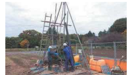
管路更新地質調査の様子
