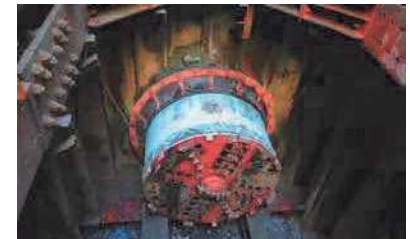
推進工法(到達)の様子
