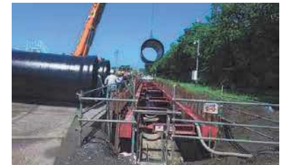
場内配管工事の様子
