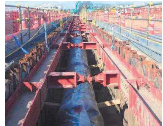
管路布設状況
