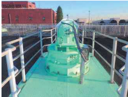
沈でん池掻寄機駆動装置
