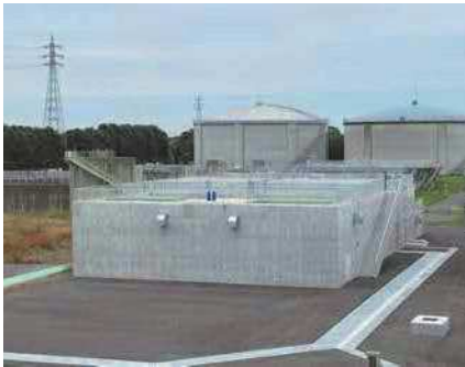
行田浄水場新着水井
