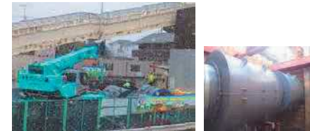
施工状況及び耐震補強接手設置状況
