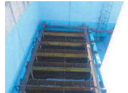
ろ材更生及び防食塗装施工後の様子
