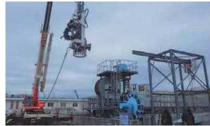
吸砂装置（4号）の取付の様子
