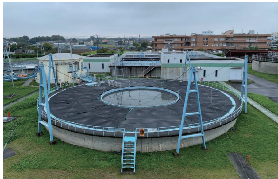
柿木浄水場1号高速沈でん池（廃止対象施設）
