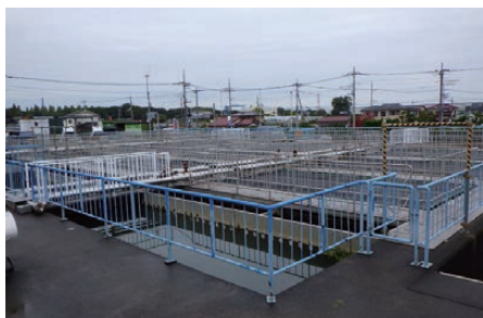
柿木浄水場2系沈でん池
